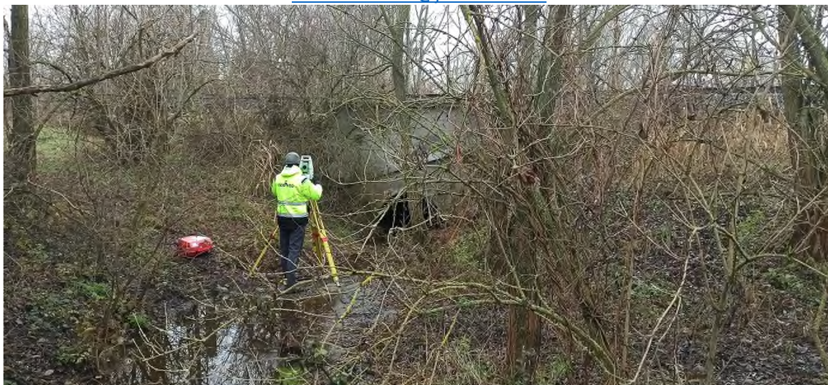
Geodetické zameranie skutkového stavu priepustu
