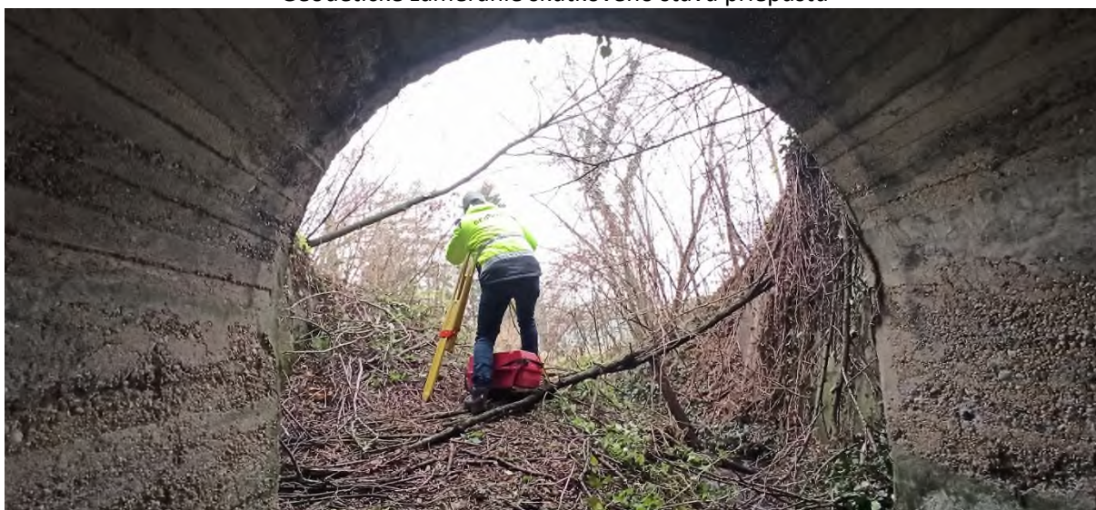
Geodetické zameranie skutkového stavu priepustu
